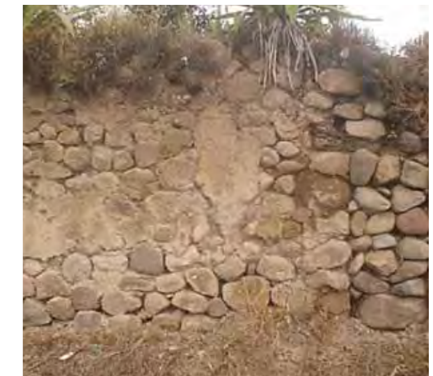
Mampostería de piedra
