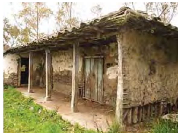
Pilar de vivienda
