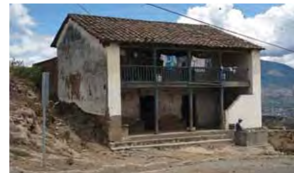
Techo a dos aguas
