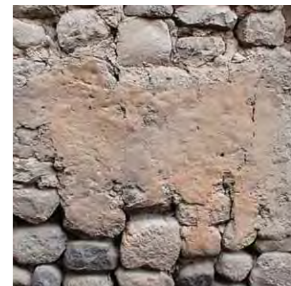
Revoque. Pared de construcción incaica, estilo pirka, Caranqui
