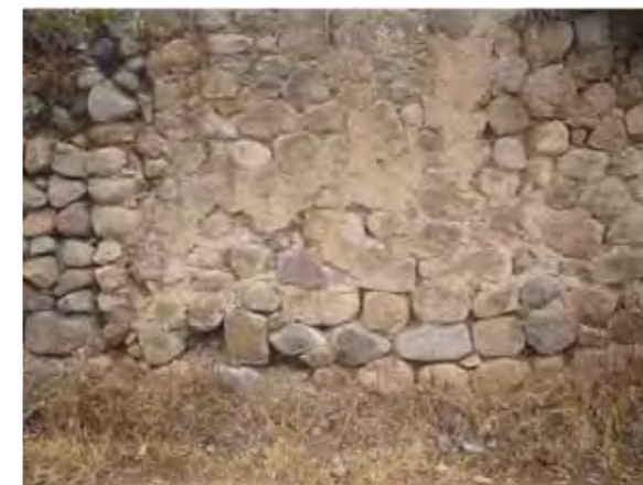
Aspecto exterior actual de un edificio incaico en Caranqui, Imbabura
