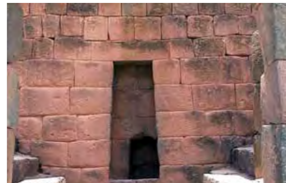
Jamba. Ingapirca, Cañar
