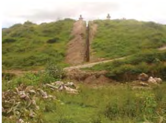
Tola de Caranqui afectada por cruce de tubería para agua potable
